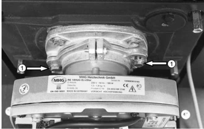
Abb. 32: Brennerbefestigungsschrauben
